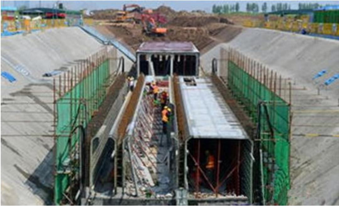
图 6-2 综合管廊施工参考图
