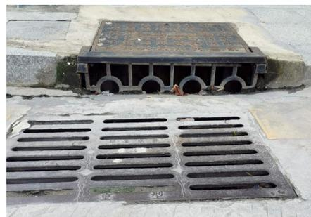
3.3.2 机动车道上的雨水口，应采用 750 × 450mm 重型球墨铸铁防盗型雨水算子及铸铁算圈，算子试验荷载为 400kN。
