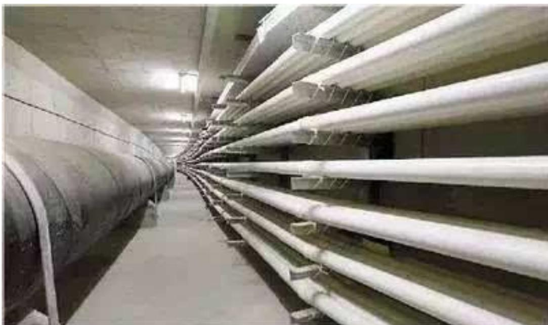
图 6-1 典型综合管廊布置示意图
