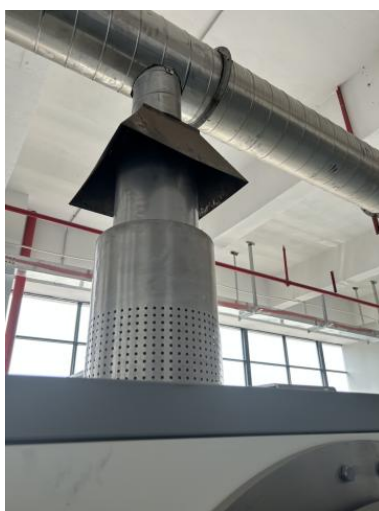
图 4-3 隧道炉、UV 固化炉排气口处集气装置示意图
