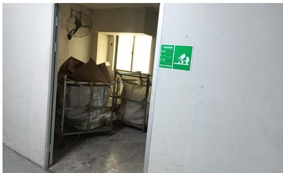
一般固废间照片1
